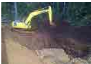
Pembuatan Cek Dam Check Dam Construction
